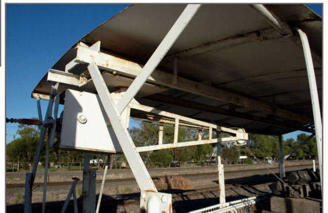
Photo 20. Crane @ B-end. 13.3.2015. Taillem Bend. Norm Bray photo.
